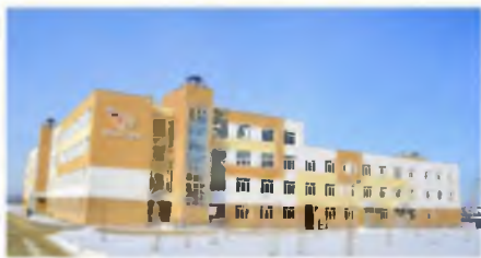
Строительство школы на 1225 учащихся по ул. Зеленина в г. Орле
