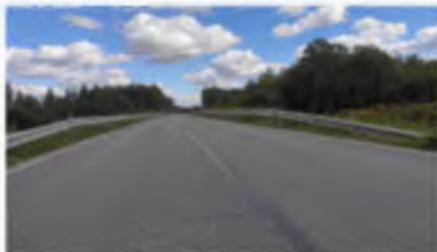
Строительство искусственного сооружения через р. Сила в д. Тэйкине Орловского муниципального округа Орловской области
