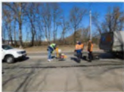
Капитальный ремонт автомобильной дороги общего пользования регионального значения Южный подъезд к г. Мценск на участке км 4+810 – км 6+270
